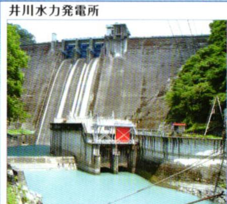
井川ダムを有する井川水力発電所では、私たちの暮らしを支える電気をつくっています。井川ダムは日本初の中空重力式ダムとして知られています。また、建設の陣頭指揮を執った中部電力初代社長・井上五郎にちなんで「井川五郎ダム」の愛称でも呼ばれています。
