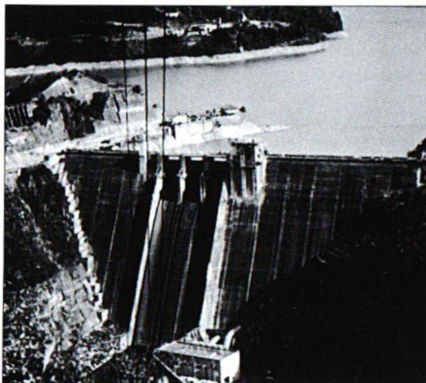
●井川ダム 昭和32年に完成、またの名を五郎ダムと呼び日本で最初の中空重力式ダムです。出力62,000KW（最大）貯水量15,000万t（最大）、高さ100M、長さ243Mです。
